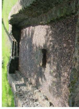
Restauriertes Steinhaus mit Fundament eines Stutzpfeilers im Zentrum
